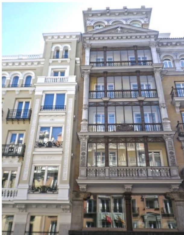
Figure N° 4.9.1 a : Exemple d'usage des oriels dans les pays européens pour des balcons peu profonds (cas situés en Espagne) [Migneron et collab., GRAP]
