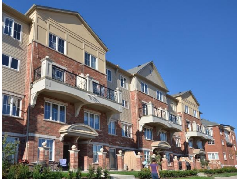
Figure N° 4.10.3 : Exemple de discontinuités dans la finition extérieure d'une façade 33
