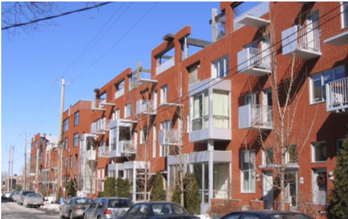
Figure N° 4.9 : Exemple d'intégration d'un oriel sur les balcons d'un immeuble résidentiel d'Outremont à Montréal [Migneron et collab., GRAP]
